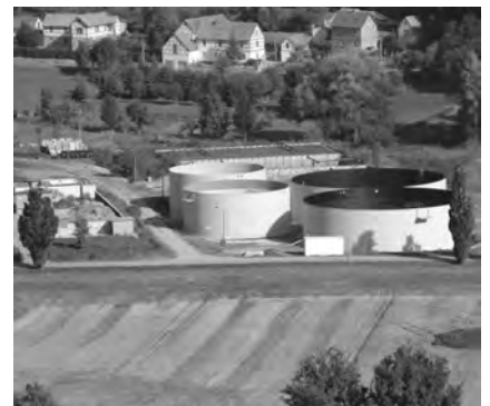
Bau der Biogasbehälter am Standort der Agrar-genossenschaft Reinstädter Grund
